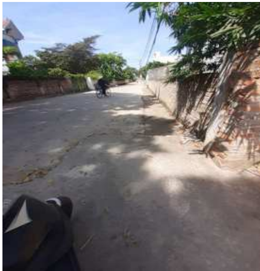
Hệ thống thoát nước chung của phường Trung Sơn Tràm
