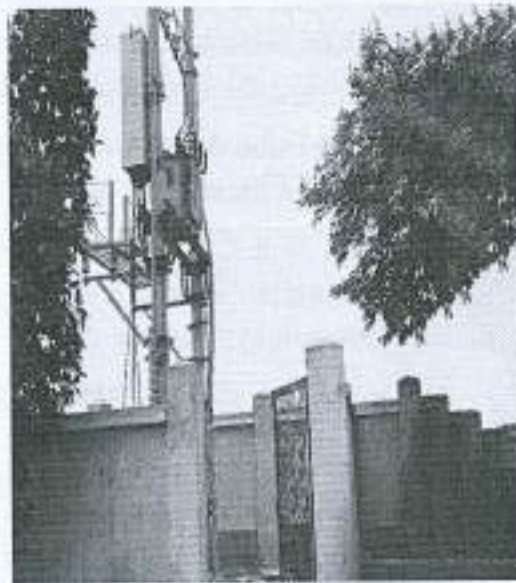
Hình 1. 5. Hệ thống cấp điện trung thế và trạm biến áp mằm non
