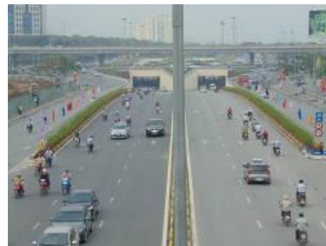
Hầm chui Trung Hòa
