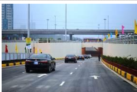
Hầm Trung Hòa
