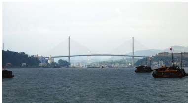
Cầu Bãi Cháy (Nguồn: https://commons.wikimedia.org )
